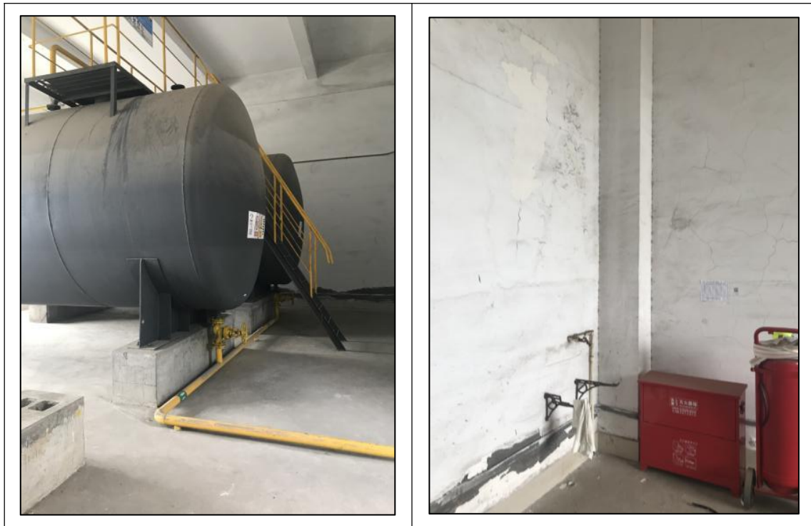
图 4-1 储罐现场照片
