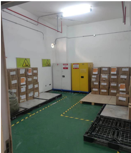
危废仓库内部（环氧地坪）
