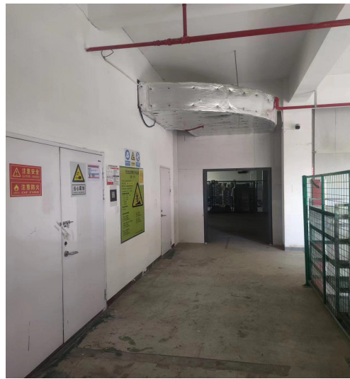
危废仓库监控
