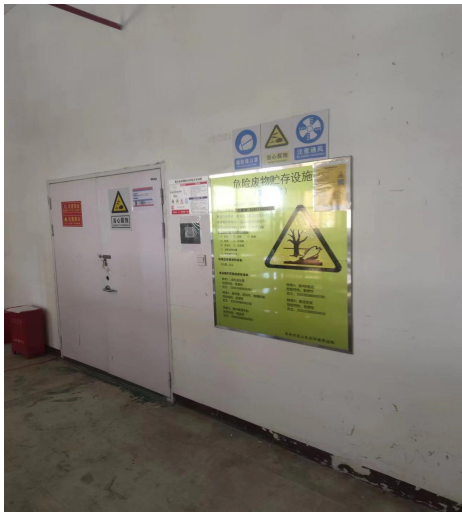
危险废物贮存设施
