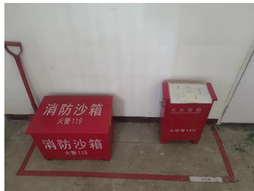
危废仓库防泄漏、消防物资
