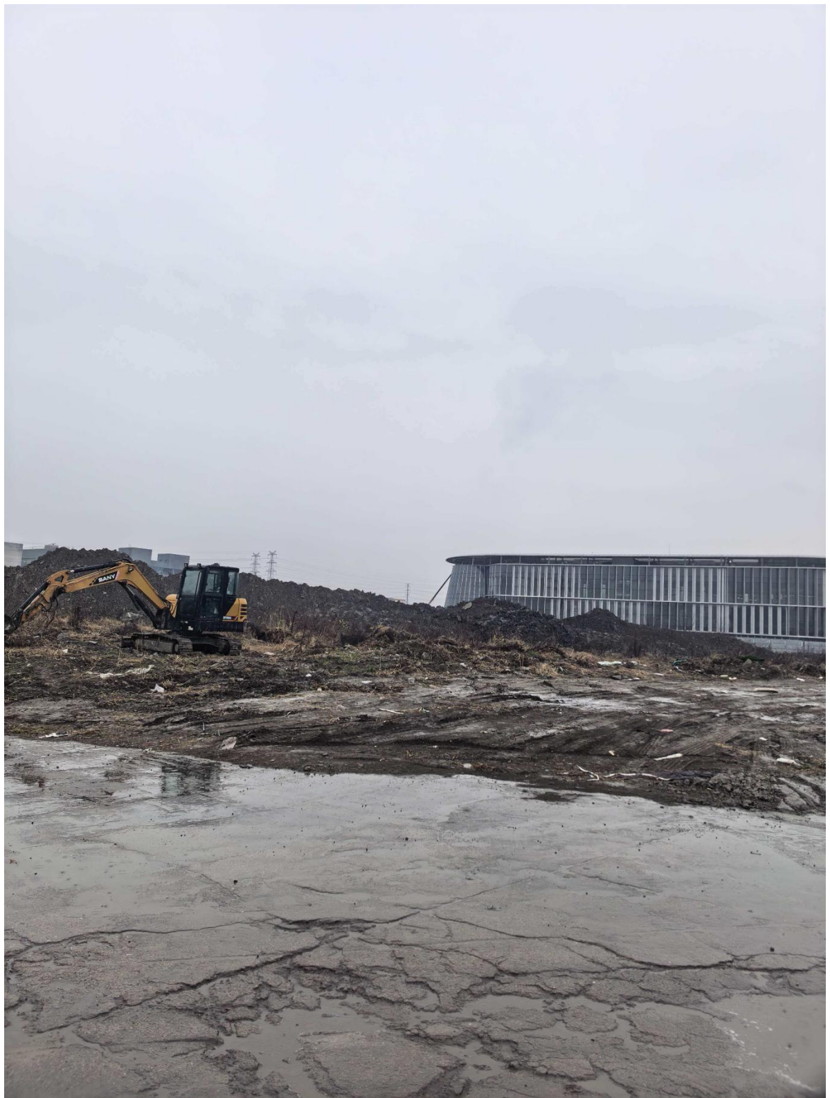
图 2-2 淤泥堆场现场图
