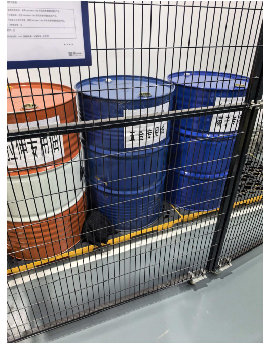
危废仓库防泄漏托盘
