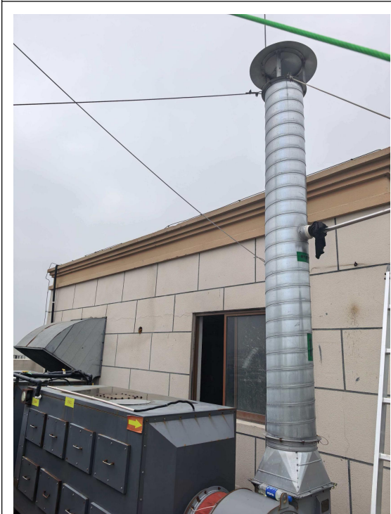
DA001 废气装置及排气筒
